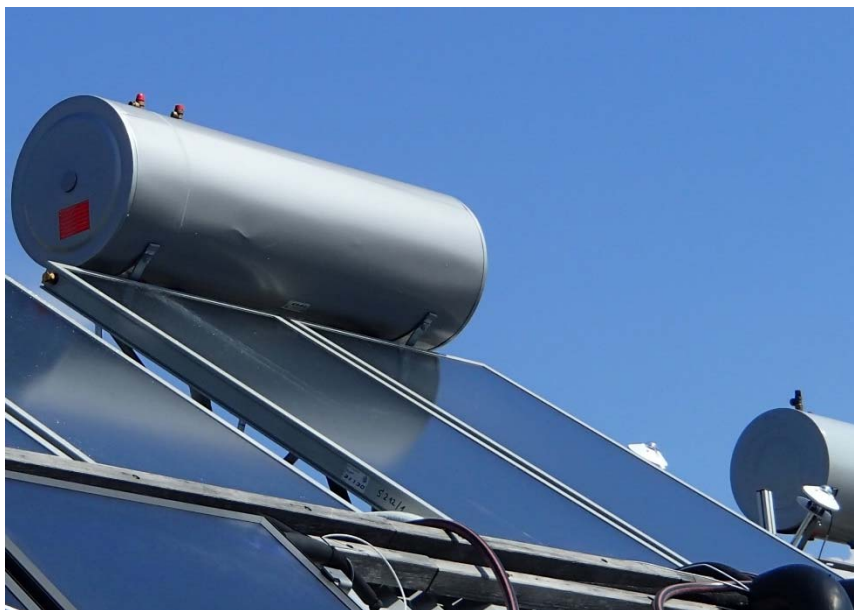
Fig. 1: Thermosiphonsystem NATURAL SOL 280 V2
