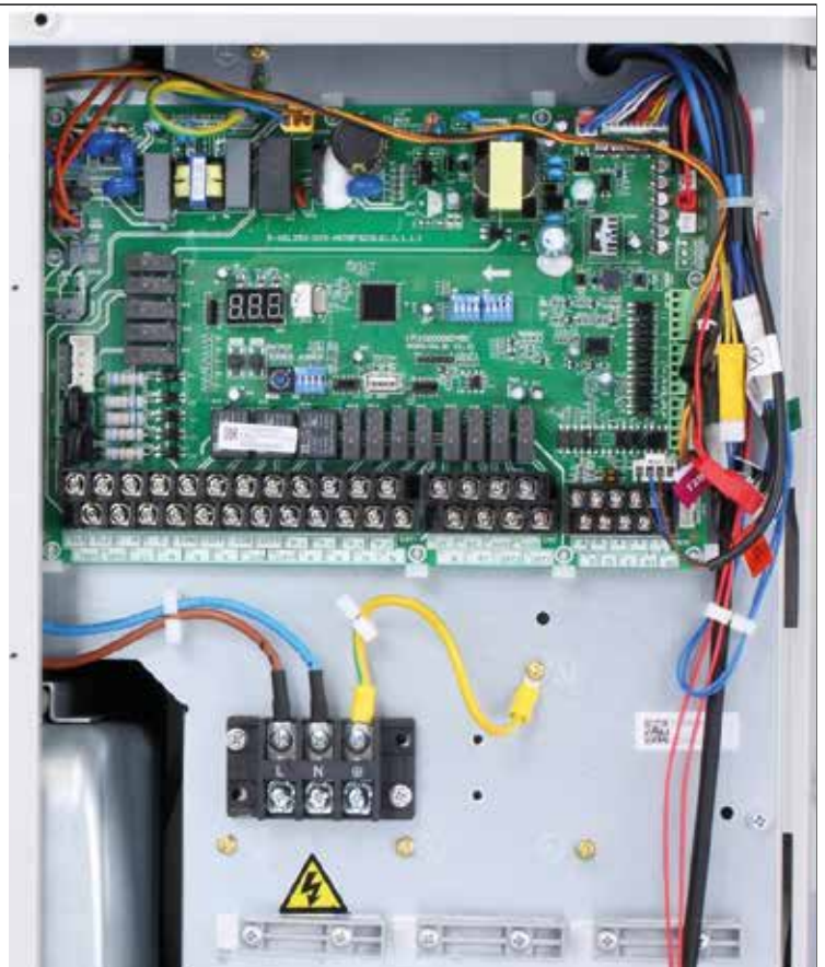
Esempio foto morsettiera con riferimento a MAGIS M4-6 Monofase
